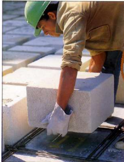
Figura 4.11 – Laje nervurada moldada no local com enchimento em bloco de concreto celular autoclavado. [73]
