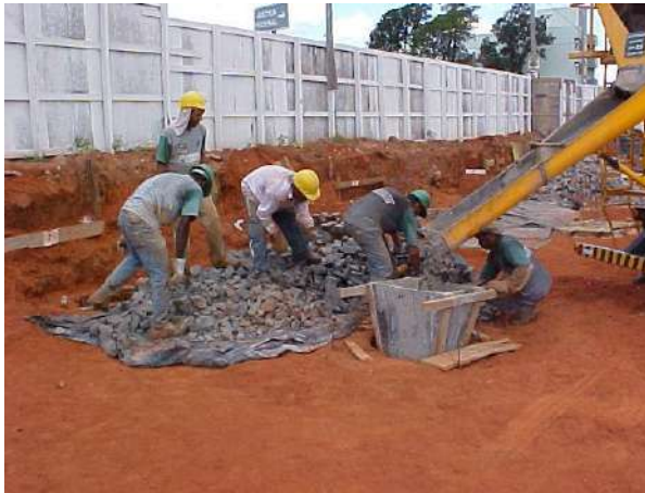
Figura 4.38 – Lançamento do concreto no tubulão e adensamento do concreto do topo do fuste.
