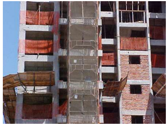
Figura 4.27 – Pilares em um edifício de múltiplos pavimentos.
