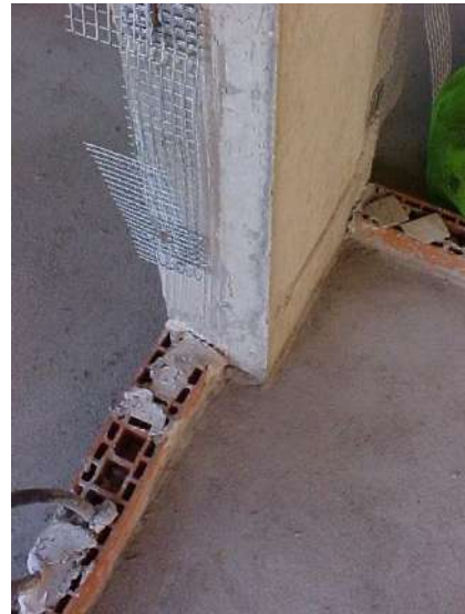
Figura 4.30 – Detalhe da ligação de pilar de edifício com a parede de vedação.
