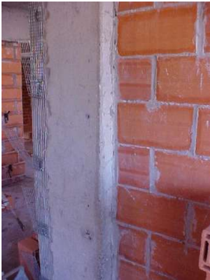
Figura 4.30 – Detalhe da ligação de pilar de edifício com a parede de vedação.
