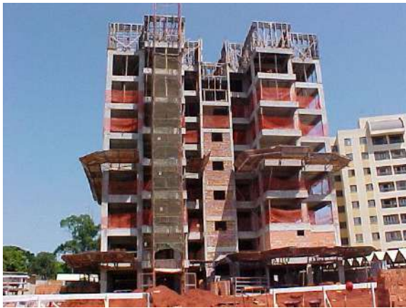
Figura 4.27 – Pilares em um edifício de múltiplos pavimentos.
