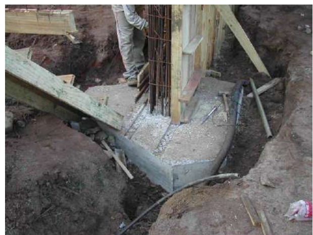
Figura 4.39 – Blocos de fundação já concretados.
