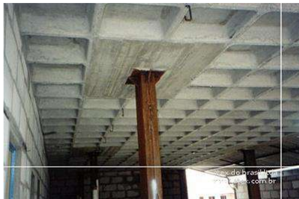
Figura 4.12 – Lajes nervuradas sem material de enchimento. [74]
