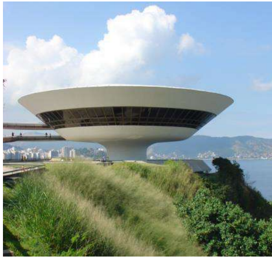
Figura 4.4 – Exemplo de estrutura com superfícies em casca.
