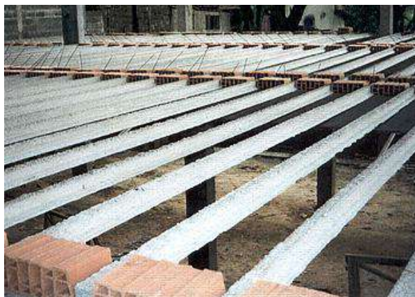
Figura 4.15 – Laje pré-fabricada com nervura protendida.
