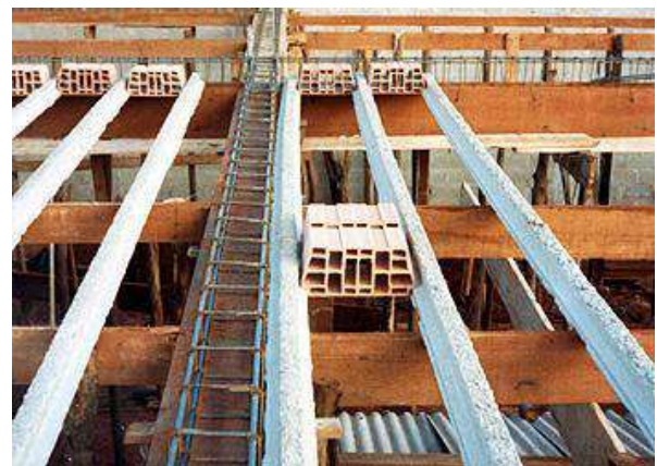
Figura 4.15 – Laje pré-fabricada com nervura protendida.
