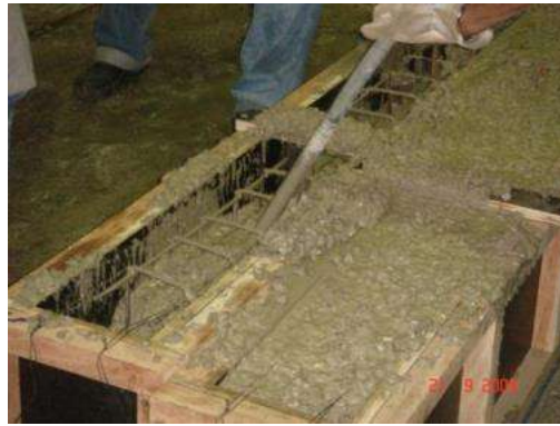
Figura 1.1 – Preenchimento de fôrma com concreto e adensamento interno com vibrador de agulha. [2]
