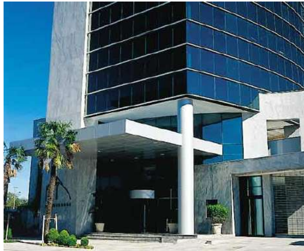
Figura 4.26 – Pilar na fachada de edifício.
