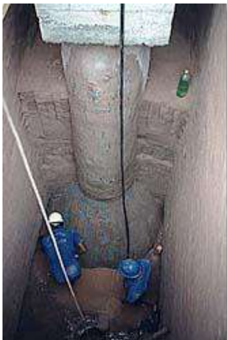
a) tubulão em vistoria;
