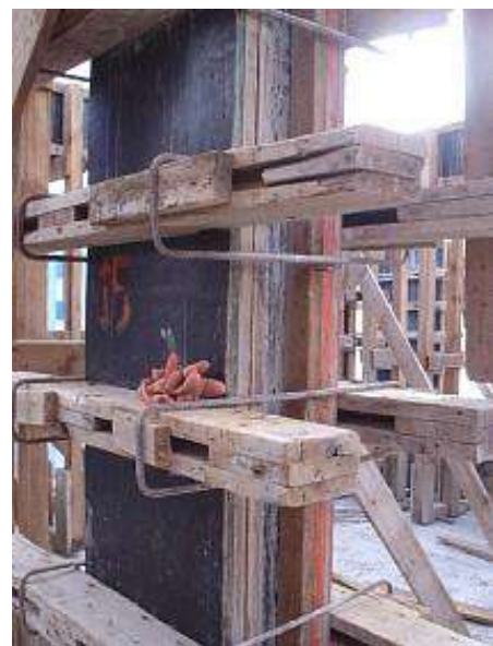
Figura 4.28 – Montagem de um pilar e detalhe da fôrma.
