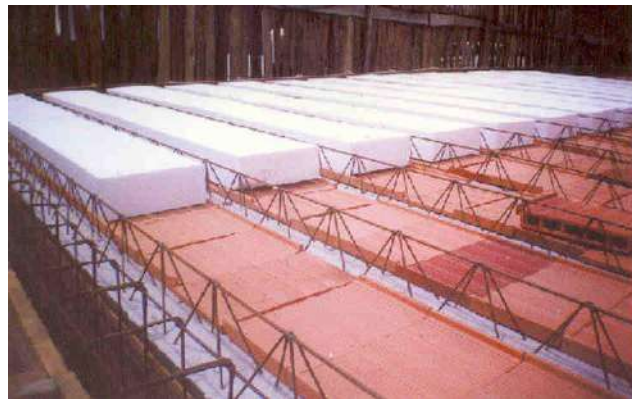
Figura 4.14 – Laje pré-fabricada do tipo treliçada com enchimento em blocos cerâmicos e de isopor.
