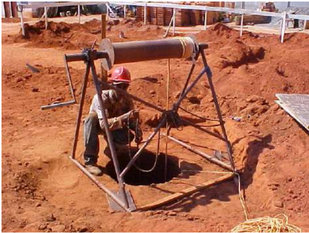
Figura 4.37 – Tubulões sendo escavados manualmente e com equipamento.
