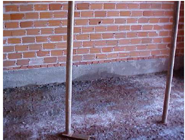
Figura 4.21 – Viga invertida na base de uma parede.
