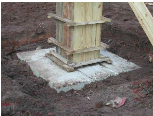
Figura 4.39 – Blocos de fundação já concretados.
