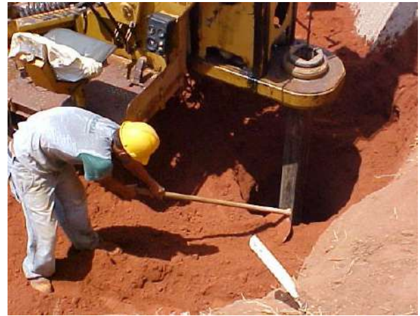
Figura 4.37 – Tubulões sendo escavados manualmente e com equipamento.
