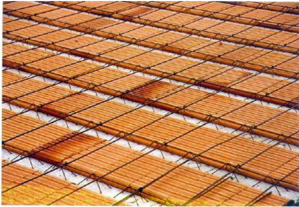
Figura 4.13 – Exemplo de laje nervurada pré-fabricada do tipo treliçada. [75]
