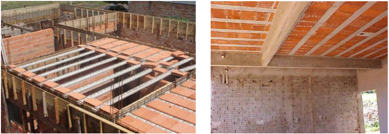
Figura 4.23 – Exemplos de vigas em sobrado residencial.
