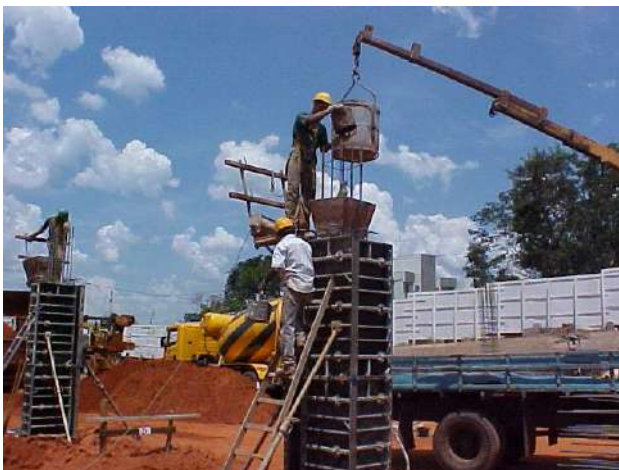
Figura 4.31 – Pilar sendo concretado e detalhe da fôrma.
