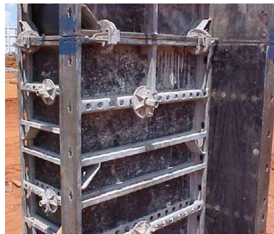
Figura 4.31 – Pilar sendo concretado e detalhe da fôrma.
