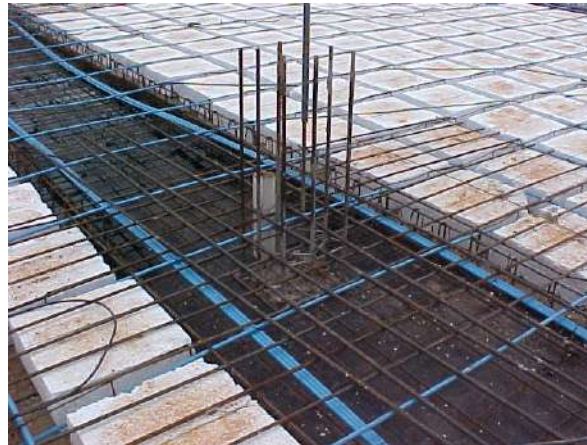
Figura 1.7 – Cordoalha de sete fios engraxada. (Fonte: Catálogo ArcelorMittal)
