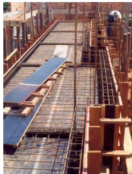
Figura 4.7 – Lajes maciças sendo concretadas e em construção.
